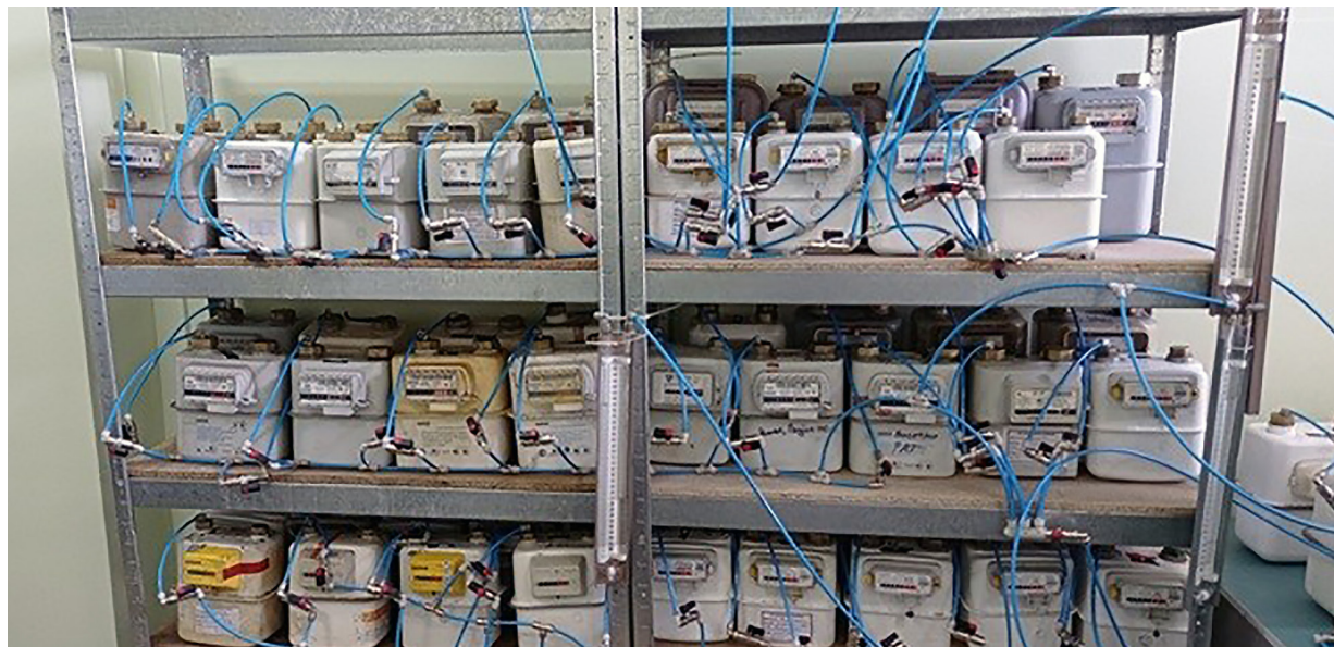
Рис. 1. Вигляд системи монтажу лічильників газу мембранного типу при перевірці на герметичність
